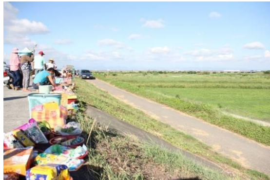
圖 6. 2015 年中港仔拜溪王；民眾自備祭品直接置於堤防之上
