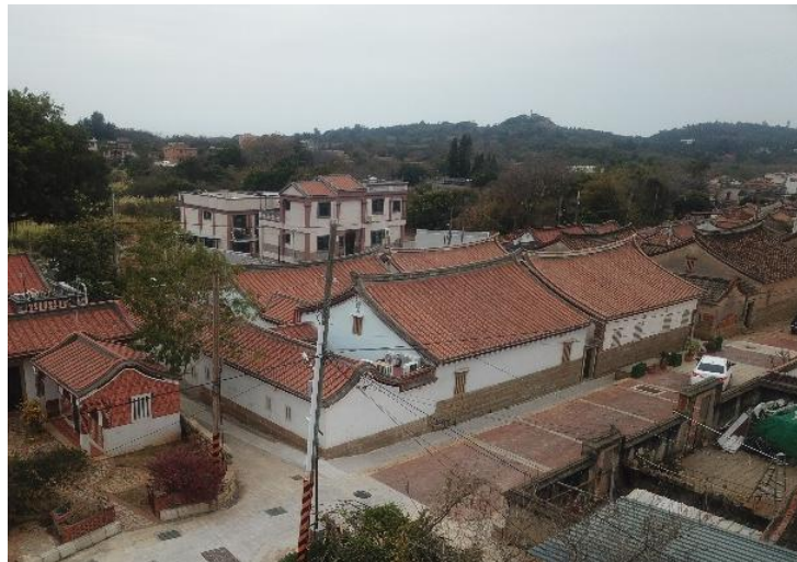
圖 2. 前水頭 9 號後側空拍現況圖 (資料來源：劉華嶽)
