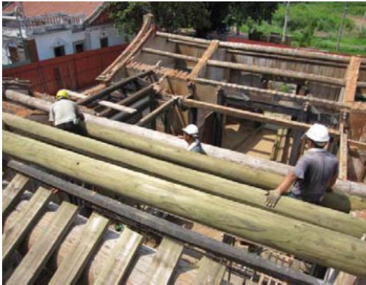
圖 7. 屋架木結構施作情況 (資料來源：前水頭 9 號及 35 號傳統建築修復工作紀錄報告書)
